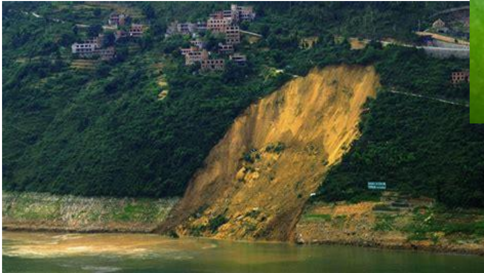
Erosion glissements de terrains
